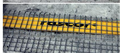
Da bei einer mechanischen Befestigung jedoch der Ausgleich zwischen Untergrund und Quellband (Montagekleber) fehlt, eignet sich diese Montageart **nur für glatte Untergründe**.
